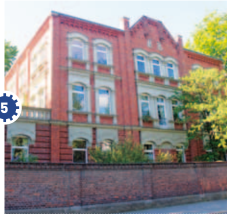
Weberei und Villen Schützenstraße (und Halle) Schützenstraße 12
